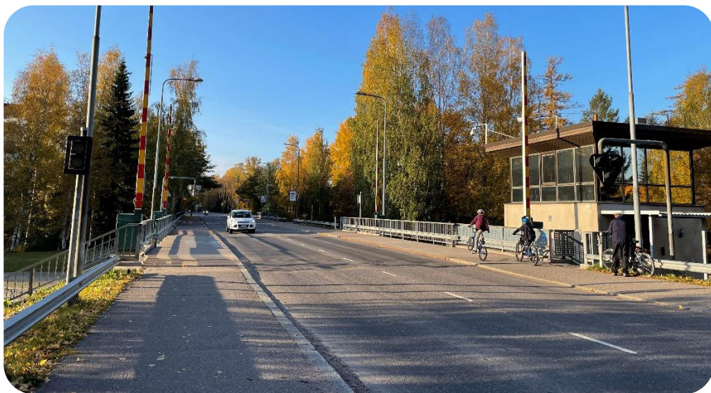
Kuva yllä: Kanavatiellä katutilasta kilpailevat kaikki liikennemuodot. Pyöräliikenteen tavoiteverkossa kaksisuuntainen pääreitti kulkee sillan eteläpuolella. Kuva oikealla: Kaupunkien/kuntien jako pyöräliikenteen tasoluokkiin. Tampereen teknillinen yliopisto.
