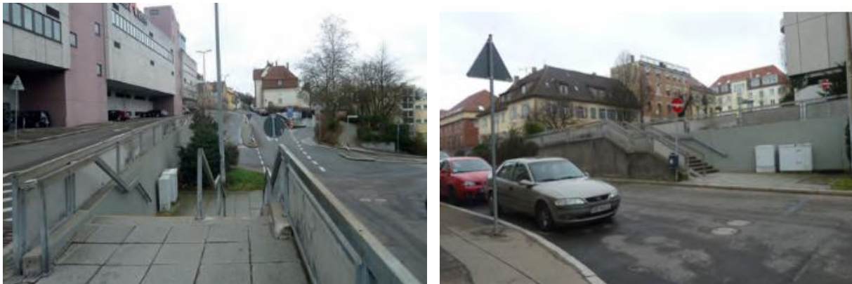
Die Stützmauer in der Charlottenstraße trennte die „Untere Stadt“ von der Innenstadt ab
