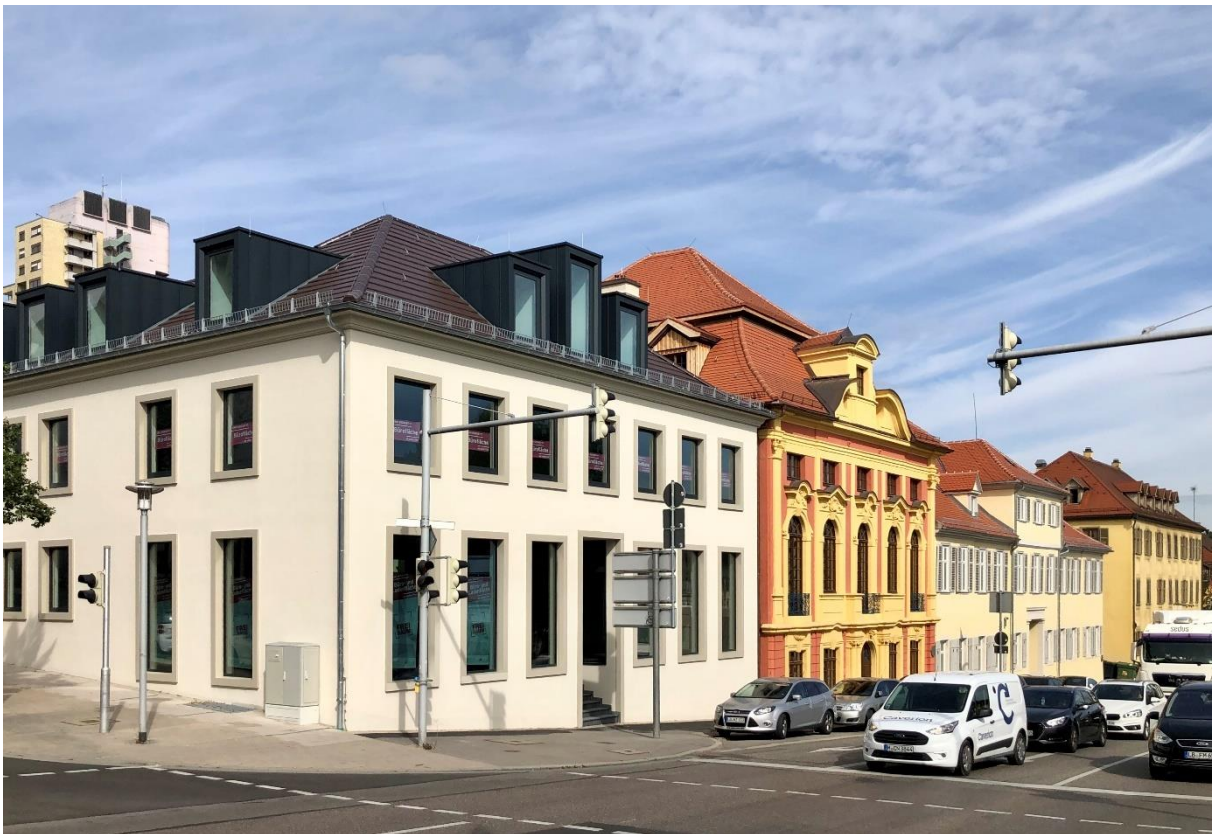
Blick von der Schlosstraße auf das historische Ensemble vor und nach der Sanierung – im Vordergrund fügt sich das neu errichtete Kaffeehaus ins Ensemble ein
