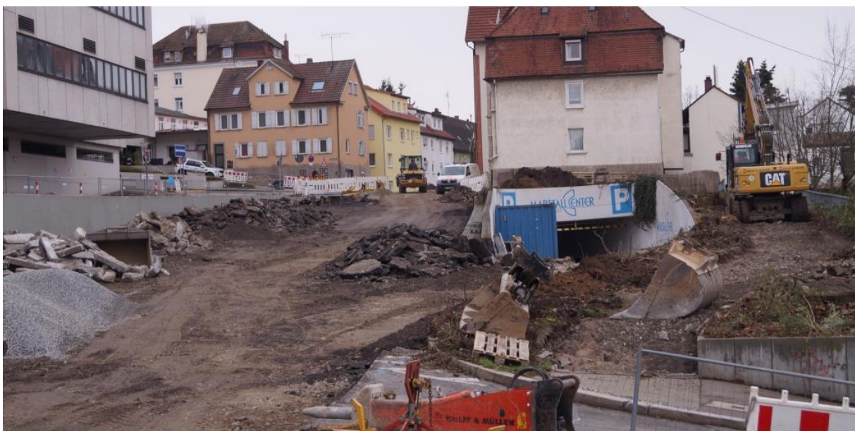
Rückbau der Tiefgaragenzufahrt
