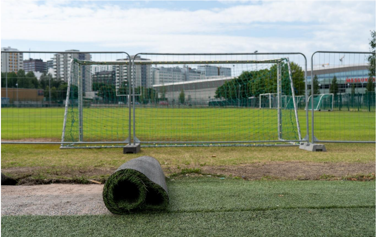
Kuva 8-1. Tekonurmea puretaan Helsingissä Käpylässä. Kuva: Veera Laanti, Helsingin kaupunki.
