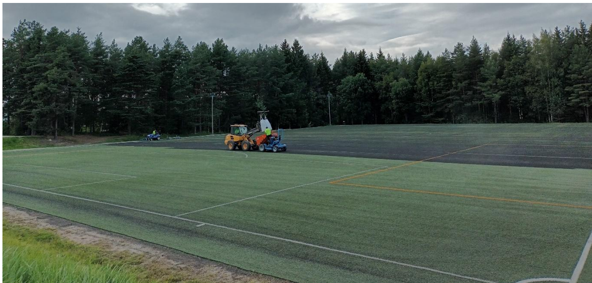
Kuva 8-3. Salon Melassuon kentälle asennettiin kesällä 2024 käytetty tekonurmi, joka oli purettu Salon urheilupuistosta. Kuvassa kentälle levitetään uutta kumirouhetäytettä.
