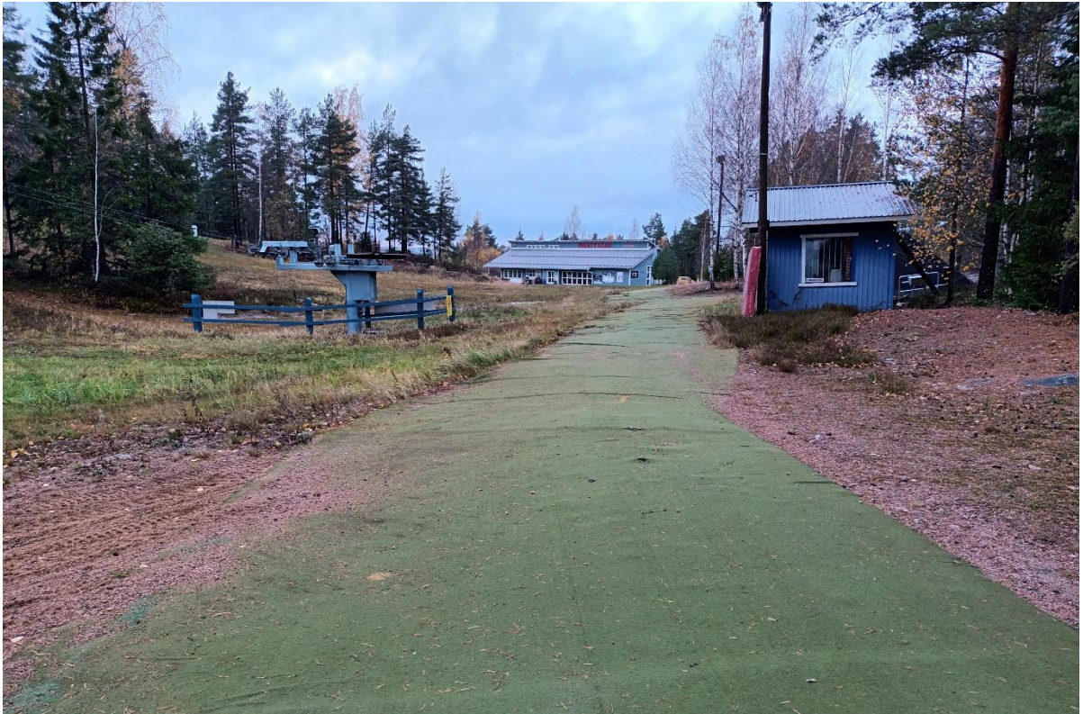
Kuva 5 Käytettyä tekonurmea on hyödynnetty käytävän pinnoitteena Salossa laskettelukeskuksessa.
