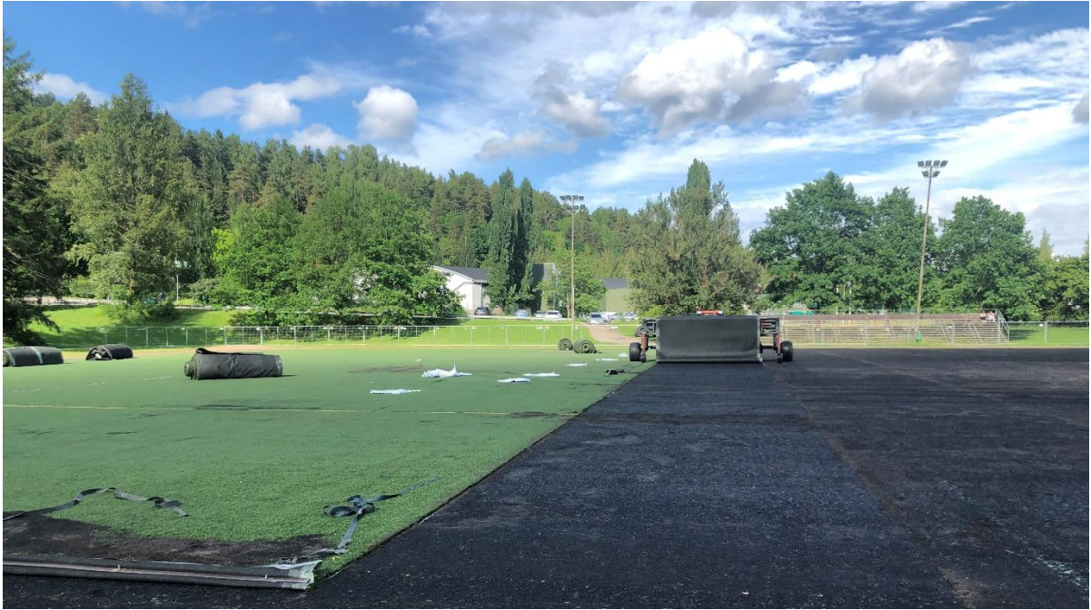
Kuva 6-3. Tekonurmikenttää puretaan Lahden Kisapuistossa. Kone poistaa täyteainetta irrottavasta ja rullattavasta tekonurmimatosta.
