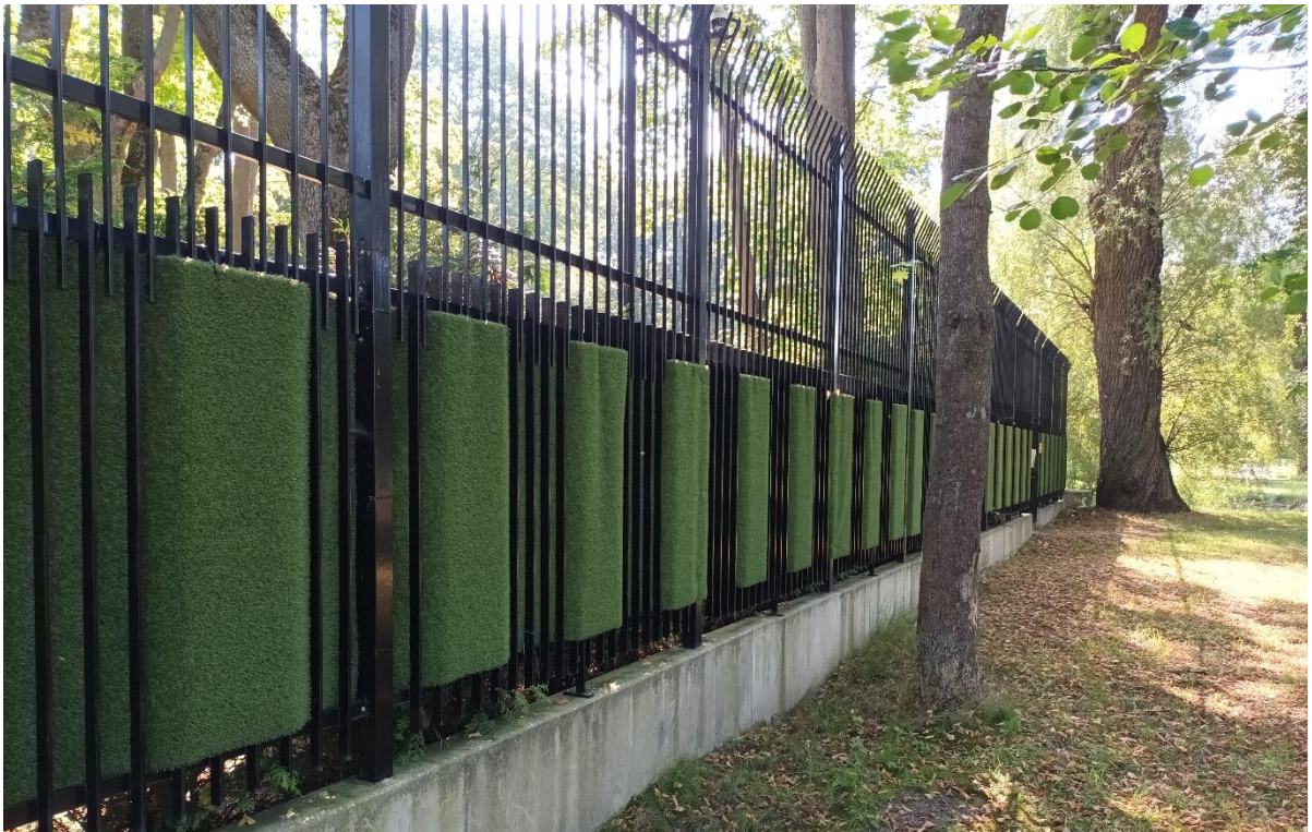
Kuva 8-6. Tallinnassa tekonurmea on käytetty aitasäleiden väliin pujotettuna näkösuojana.
