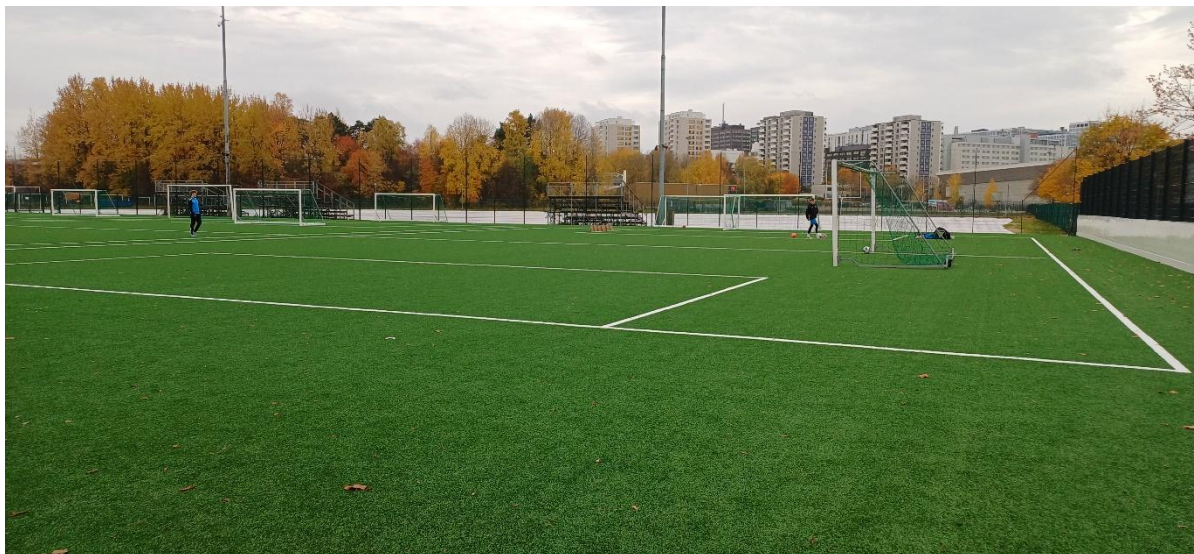
Kuva 5-1. Käpylän liikuntapuiston täyteaineeton jalkapallotekonurmi asennettiin syksyllä 2024. Tekonurmimatto asennettiin ensin kokonaan ilman täyteainetta, mutta siihen jouduttiin lisäämään jonkin verran hiekkatäyttöä, jotta matto saatiin pysymään paikoillaan. Tämän tyyppisiä tekonurmia kutsutaankin hiekkastabiloiduiksi, täyteaineettomiksi jalkapallotekonurmiksi. (Helsingin kaupunki, 2024). Kuva Ramboll.
