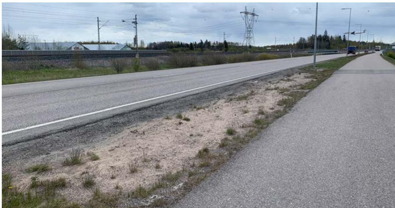
Kuva 25. Tikkurilantien suodatusrakenteet toukokuussa 2025.
