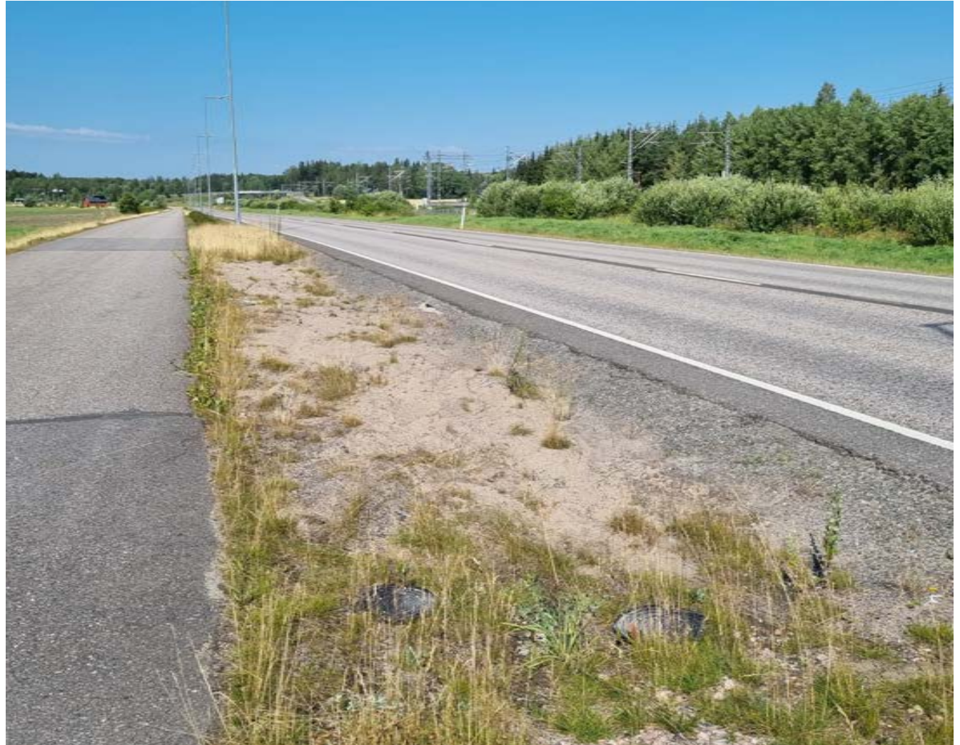
Kuva 32. Tikkurilantien suodatusrakenteet.
