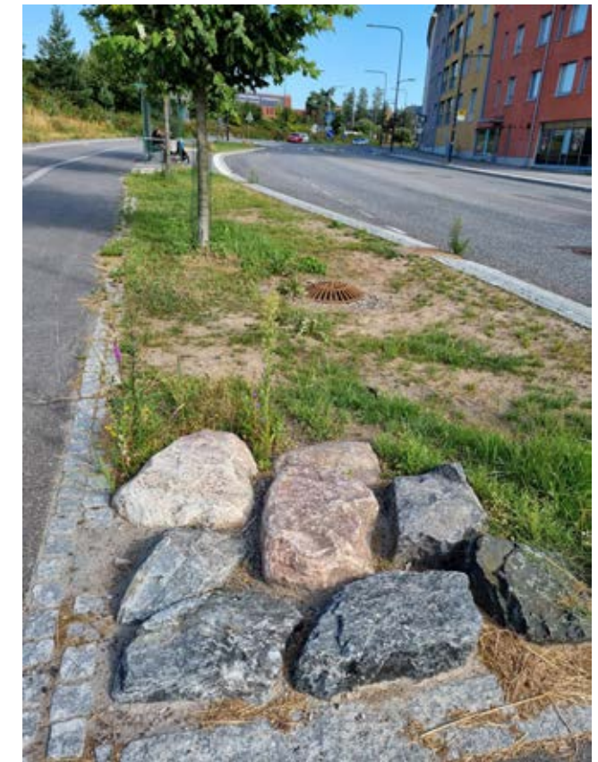
Kuva 37. Kuninkaantammen biosuodatuspainanteessa sijaitsee ylivuotokaivo.
